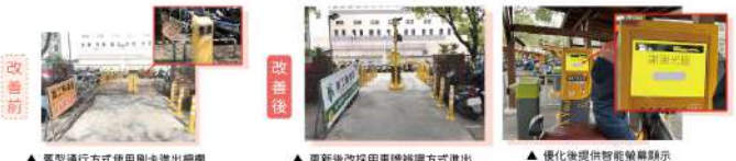
▲ 舊型通行方式使用刷卡進出柵欄 ▲ 更新後採用車牌辨識方式進出 ▲ 優化後提供智能螢幕顯示
