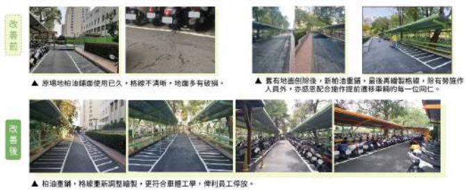
▲ 原場地柏油路面使用已久,格線不清,地面多有破損。 ▲ 原有地面剝除後,新柏油重新,最後再繪製格線,除有對原作人員外,亦感恩配合操作提前移車轉的每一位同仁。
